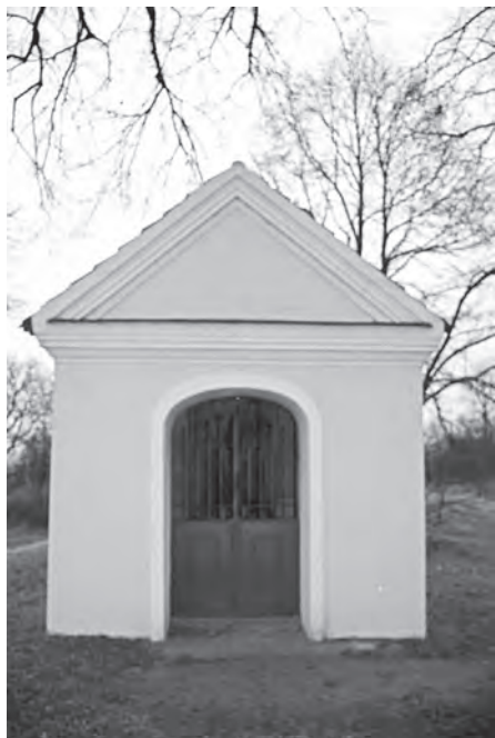
Kaple sv. Víta na místě „dlouhého domu“
